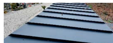
Die Kirchenmauer mit Decke vor der Sanierung ... .. und mit der neuen Blechabdeckung. (Fotos: Josef Urank)
