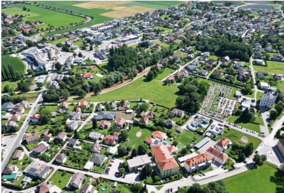
Abbildung 3: Betroffene Grundstücke Drohnenaufnahme (Quelle: LWK)
